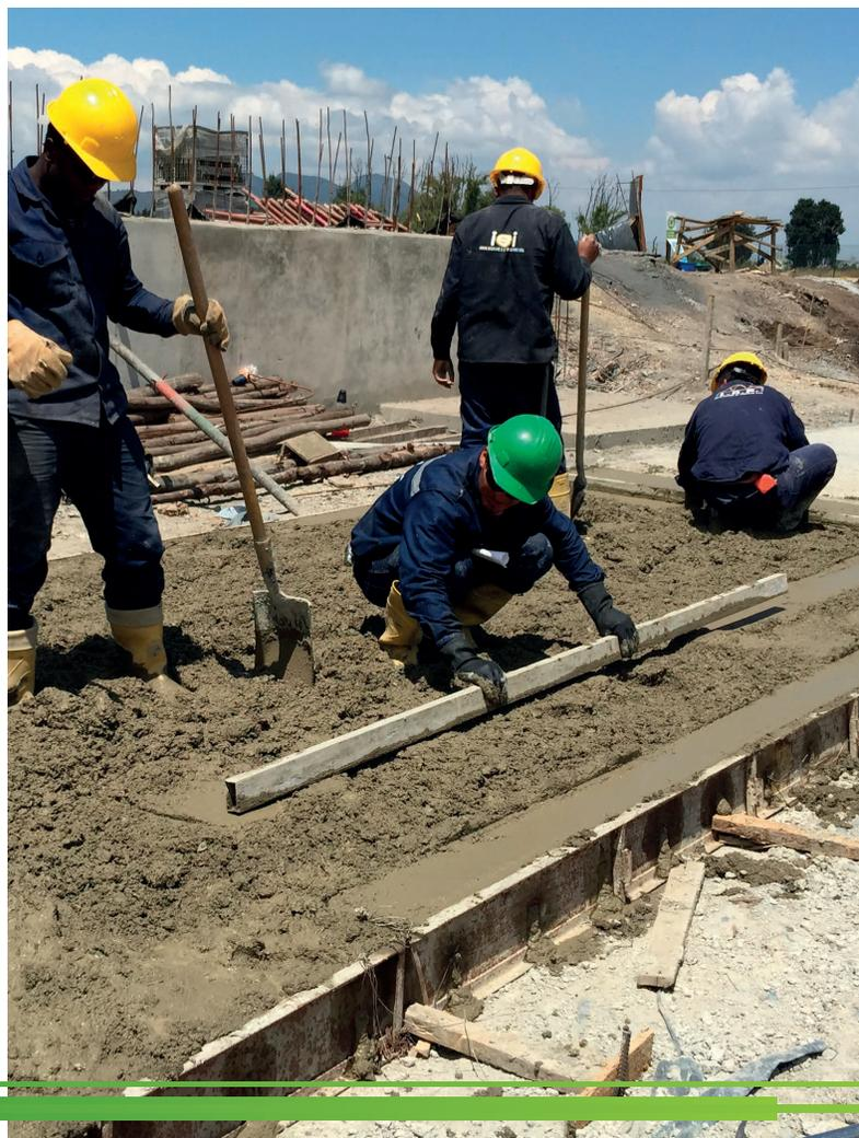
Es importante tener en cuenta que a medida que se adicione agua a la mezcla, el asentamiento se va a incrementar pero la resistencia se va a ver afectada negativamente en su desarrollo. La relación que existe entre la cantidad de agua y la cantidad de cemento es un indicador fundamental de la calidad. Las normas que rigen las especificaciones técnicas de este material en Colombia son las NTC 3459 y la NSR-10.
