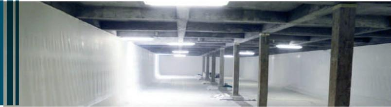
Lámina de policloruro de vinilo flexible (PVC), con una armadura de malla de fibra de poliéster. Apta para ser sometido a la intemperie y para almacenaje de agua potable.
