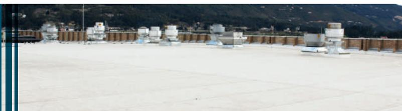
Lámina de policloruro de vinilo flexible (PVC), con una armadura de malla de fibra de poliéster. Apta para ser sometido a la intemperie, para obra nueva y rehabilitación, con reflectancia de más del 92 %.
