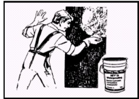
**PASO 2** – Inmediatamente después que se ha aplicado el **HEY'DI POWDER X SYSTEM**, coloque el líquido sellador **HEY'DI SEALING LIQUID** con un cepillo de cerda suave y/o a brocha limpia.
